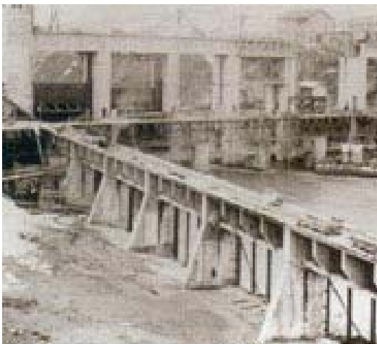
1923. Construction de l'ouvrage
